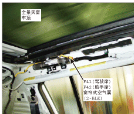
82. C-立柱顶部
